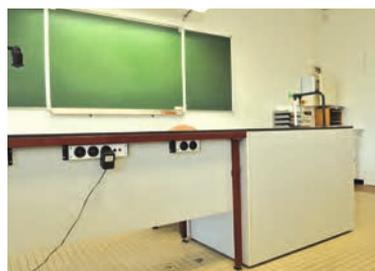
En Standard les Blocs de prises sont fixés sur le Voile de Fond des Paillasses. Les câblages circulent sous goulotte sous le plan de travail, depuis le plot Technique.
